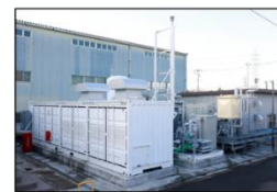
【500kWワンバックP2Gシステム全景】
