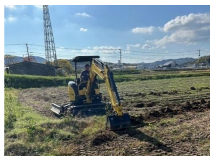
バックホウによる畦畔除去作業
