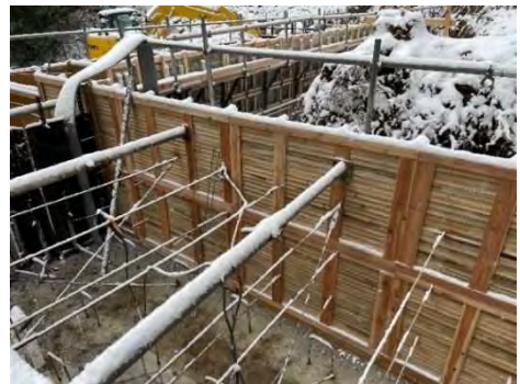
竹製残存型枠
