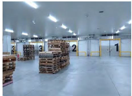
新たに完成した共同物流施設（内観）
