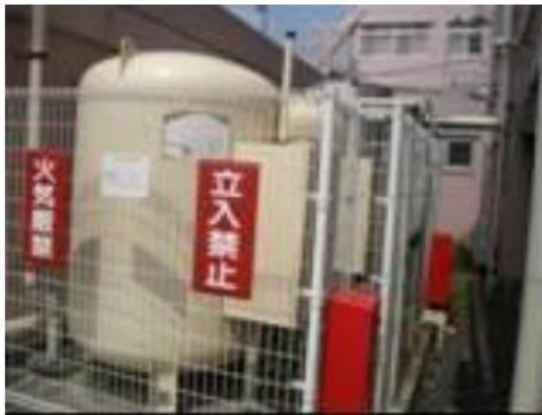
①LPガスバルク貯槽 形式：縦型 容量 980kg × 2 基 メーカー：伊藤工機(株)
