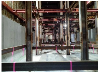
調節池内の整備状況（地下調節池築造工事）
