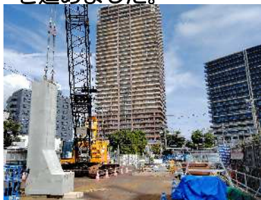
調節池部材の据付状況（地上）
