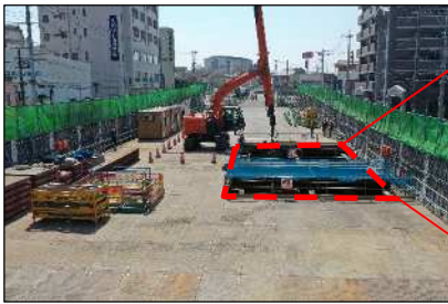
土砂掘削状況
