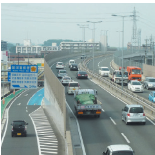
橋や道路の整備
