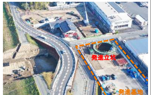
発進基地状況
