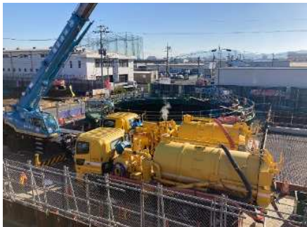
立坑内排水工（バキューム車） 【発進基地】
