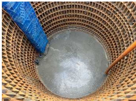
発進立坑完了 【発進基地】
