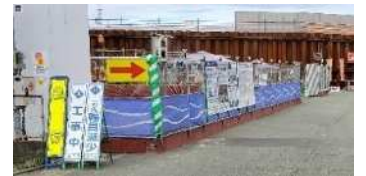
仮囲いフェンス
