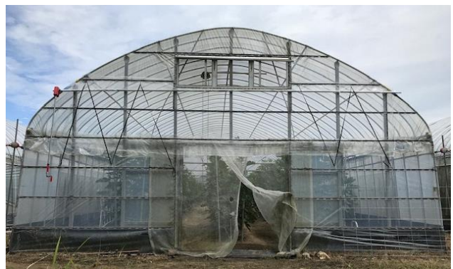
換気設備を設置したハウス
