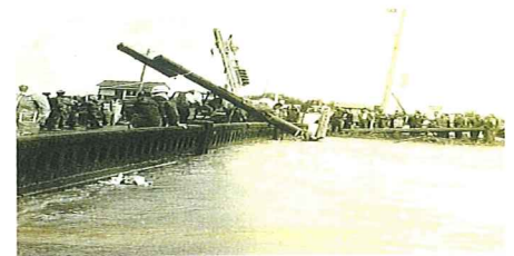
昭和44年 樋ノ口橋(田主丸町)
