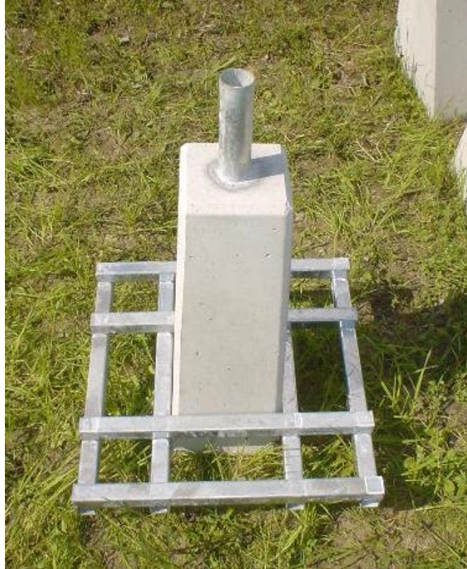
鉄製井桁を取り付けたコンクリート基礎
