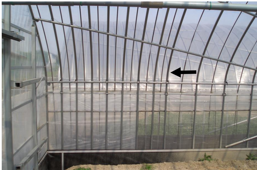
アーチパイプを通常の設置間隔の半分で取り付けて補強
