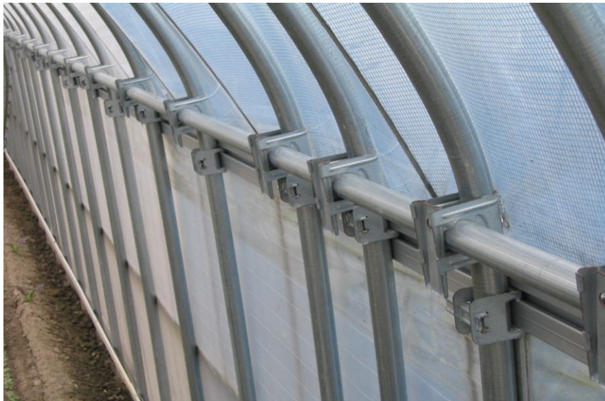
アーチパイプと母屋（胴縁）パイプの接続を鉄板製の取り付け金具で固定
