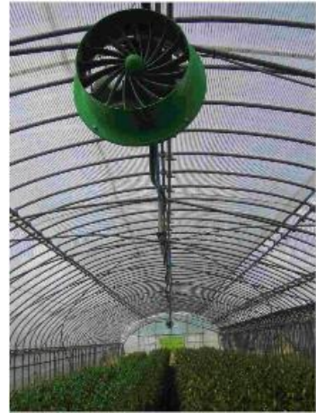
写真6 循環扇の設置
