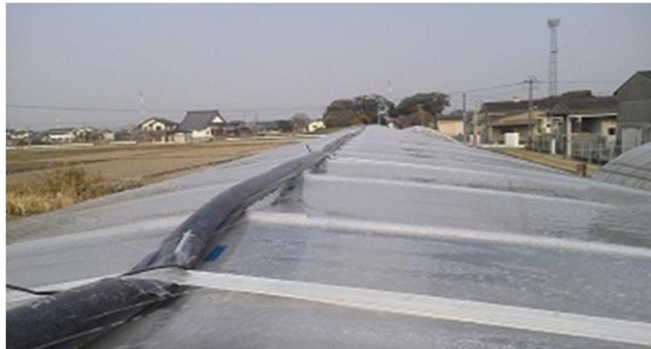
写真3 灌水チューブ設置状況
