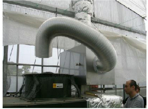
写真9、10 排熱回収装置
