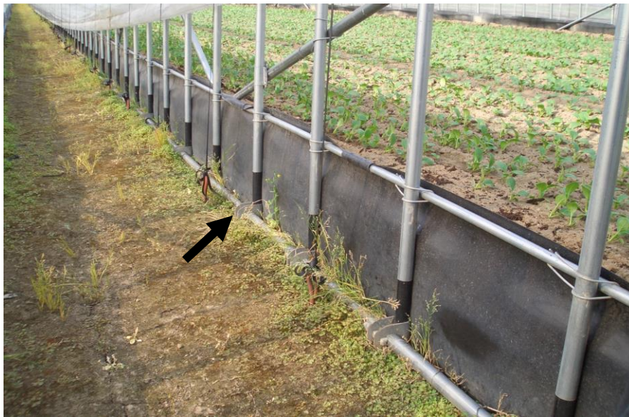
地際胴縁を取り付けて補強
