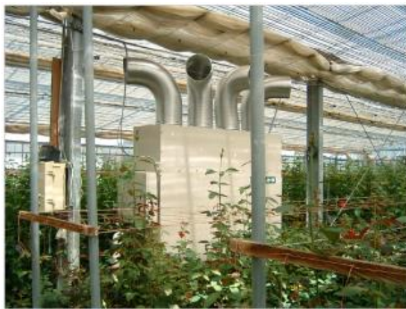
写真7、8 ヒートポンプの設置事例
