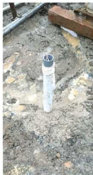
④設置完了
