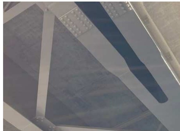
上塗塗装 完了後
