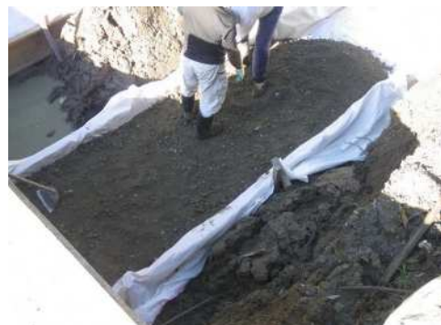
中詰め材施工状況
