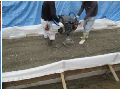
中詰め材転圧
