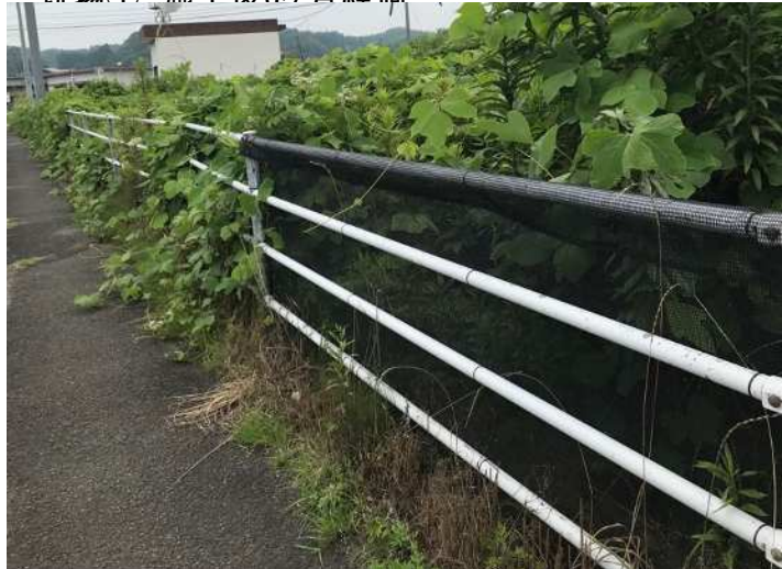
ネット施工部は歩道側への葛飛出しなし
