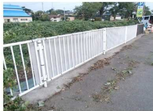
つるガード工法(歩道側)
