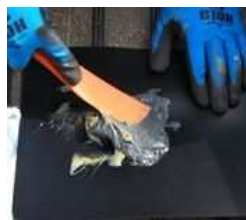
パテ練混ぜ状況
