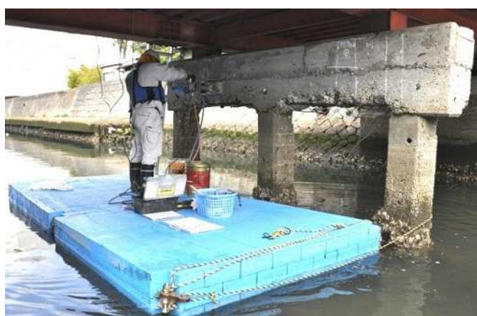
橋脚の補修状況
