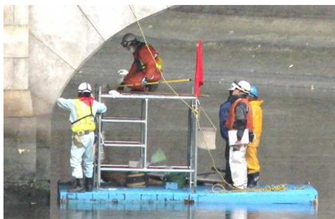
橋梁下面点検状況
