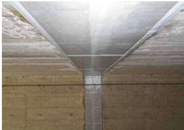
施工後(新工法)
