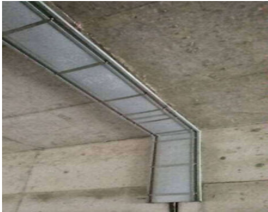
施工前(従来工法)
