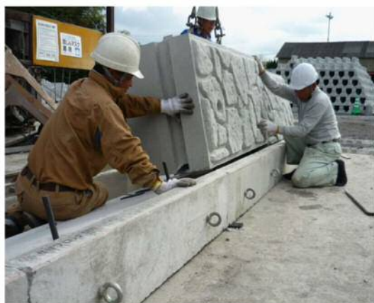
施工状況写真
