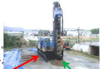
自走式クローラ型(ラバーキャタピラ装着) 乾式掘削状況
