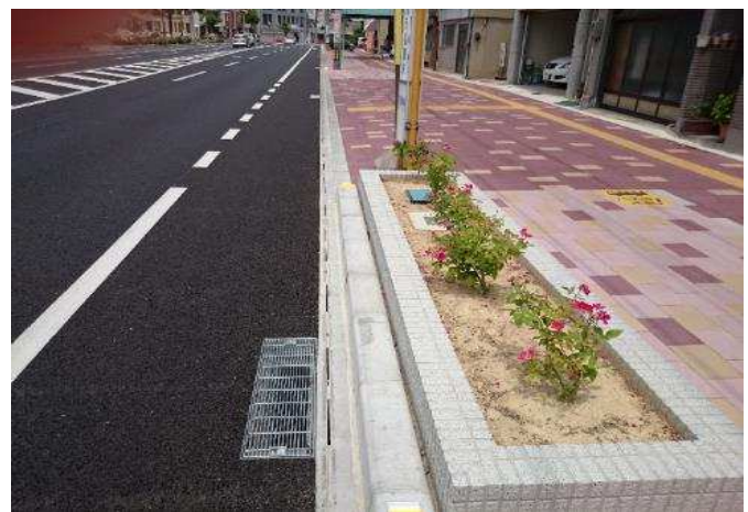
製品施工完了2
