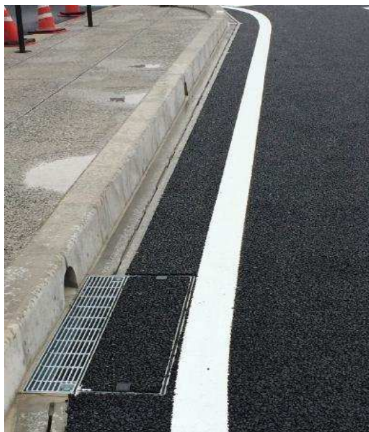
製品施工完了1
