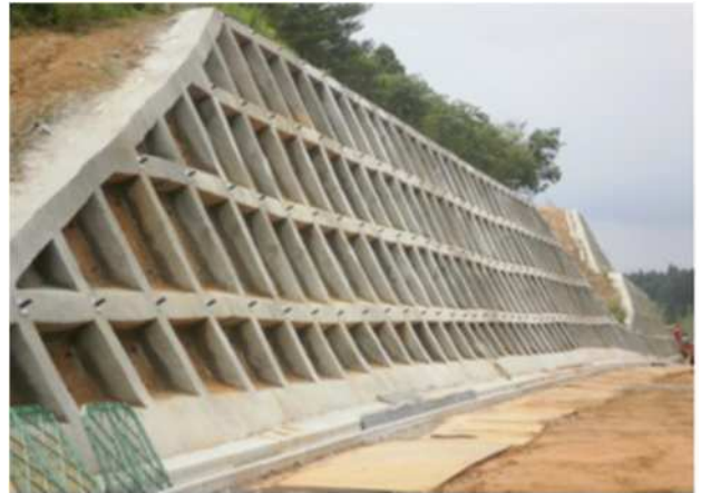
AS345-Pボルト施工完了例写真-2
