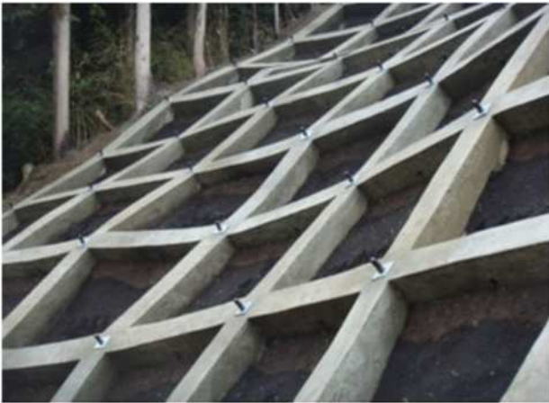
AS345-Pボルト施工完了例写真-1
