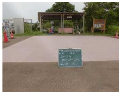
⑦2層目完了
