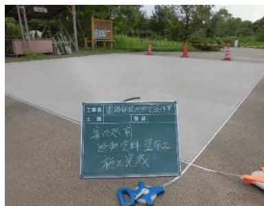
⑧施工完了
