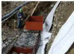
④ 製作枠を引き抜く
