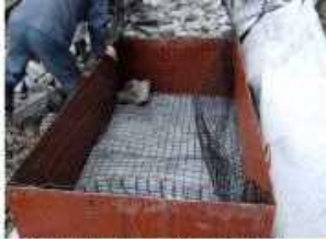
① 製作枠内にカゴを設置する
