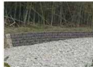
⑥ 設置完了全景
