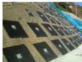
グリーンパネル敷設完了
