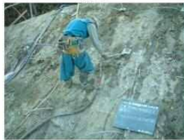
セメントミルク注入
