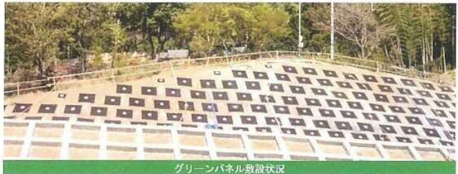
グリーンパネル敷設状況
