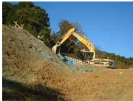
切土・のり面整形
