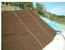
植生基材吹付完了
