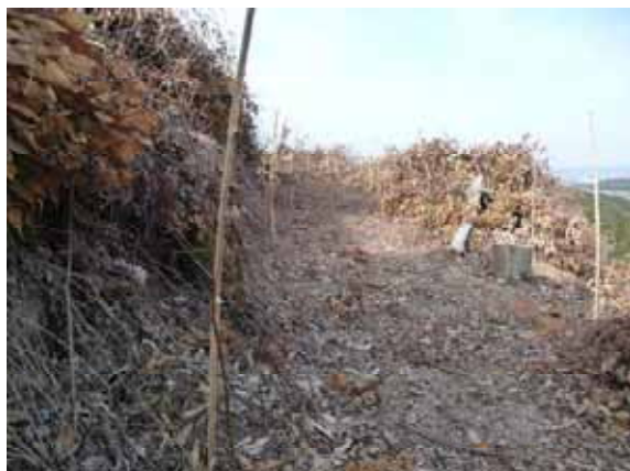
( ケヤキの植栽状況 )
