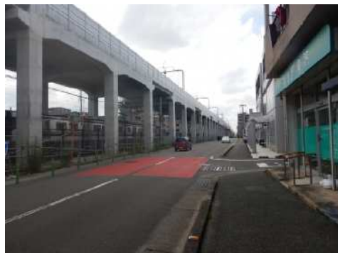
(春日原駅やや南側) この区間は先行して高架橋の上部を建設しており、現在の線路の上空に将来の線路が作られています。
