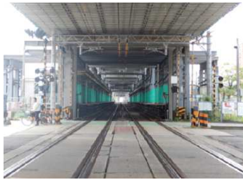
(春日原6号踏切から大牟田方面) 高架構造物の建設が進んでいます。白木原駅の建築工事が令和2年7月から始まりました。
