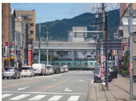
(春日原6号踏切) 令和2年6月から、県道那珂川大野城線の春日原6号踏切部により上部工架設が進められています。
