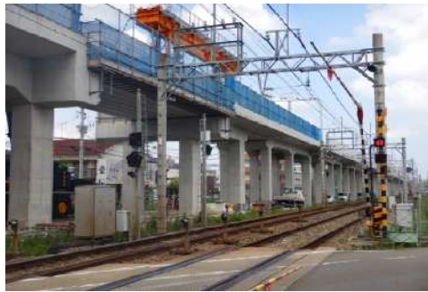
(白木原駅～下大和駅) 仮線切替後、元の線路があった箇所で、高架橋の建設を進めています。
