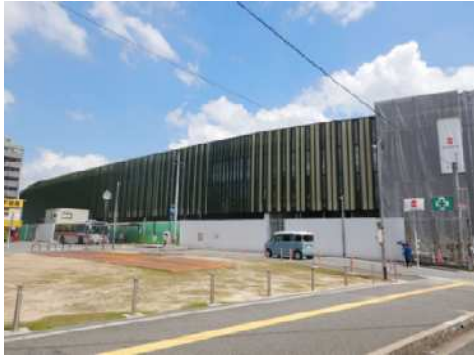
(下大和駅) 旧駅舎跡に新駅舎の建設が進められています。
