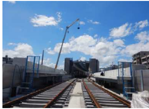
(白木原駅～下大和駅) 高架上の軌道工事が進められています。
