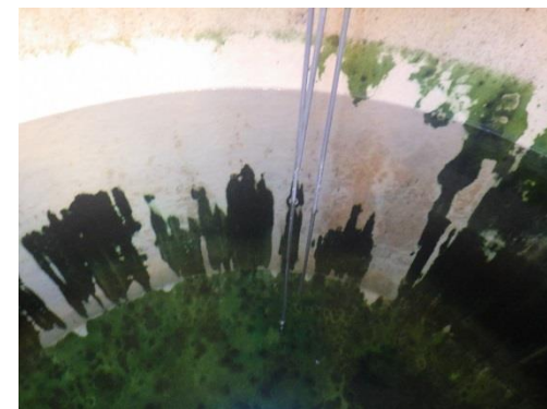
清掃前の貯水槽の内部
