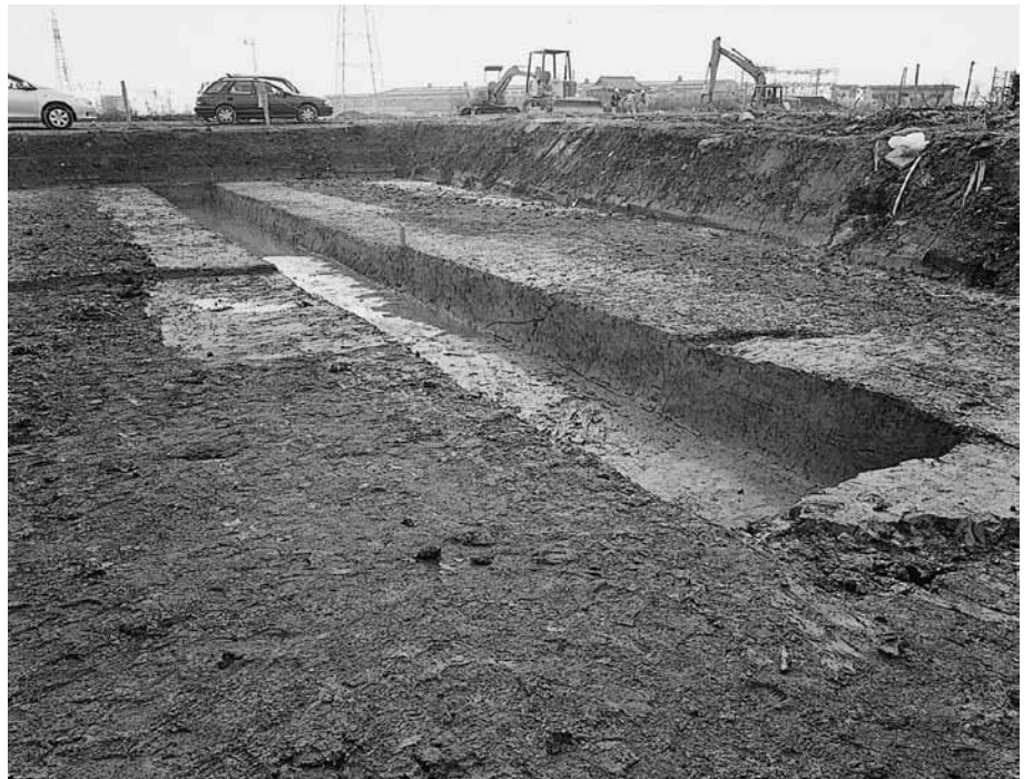
1. トレンチ（北東から）
