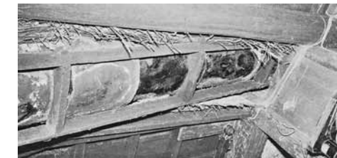
5 漏斗造の樋見上
