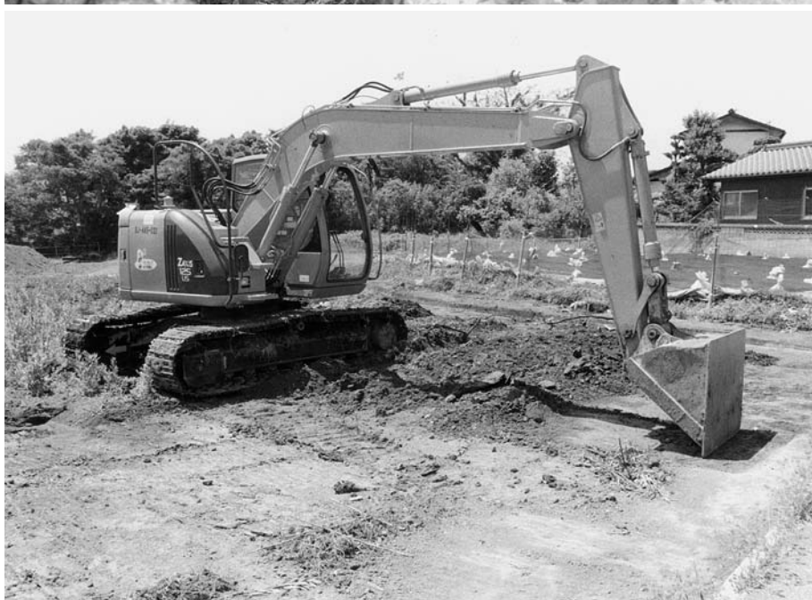
3 表土剥ぎ風景 (東から)
