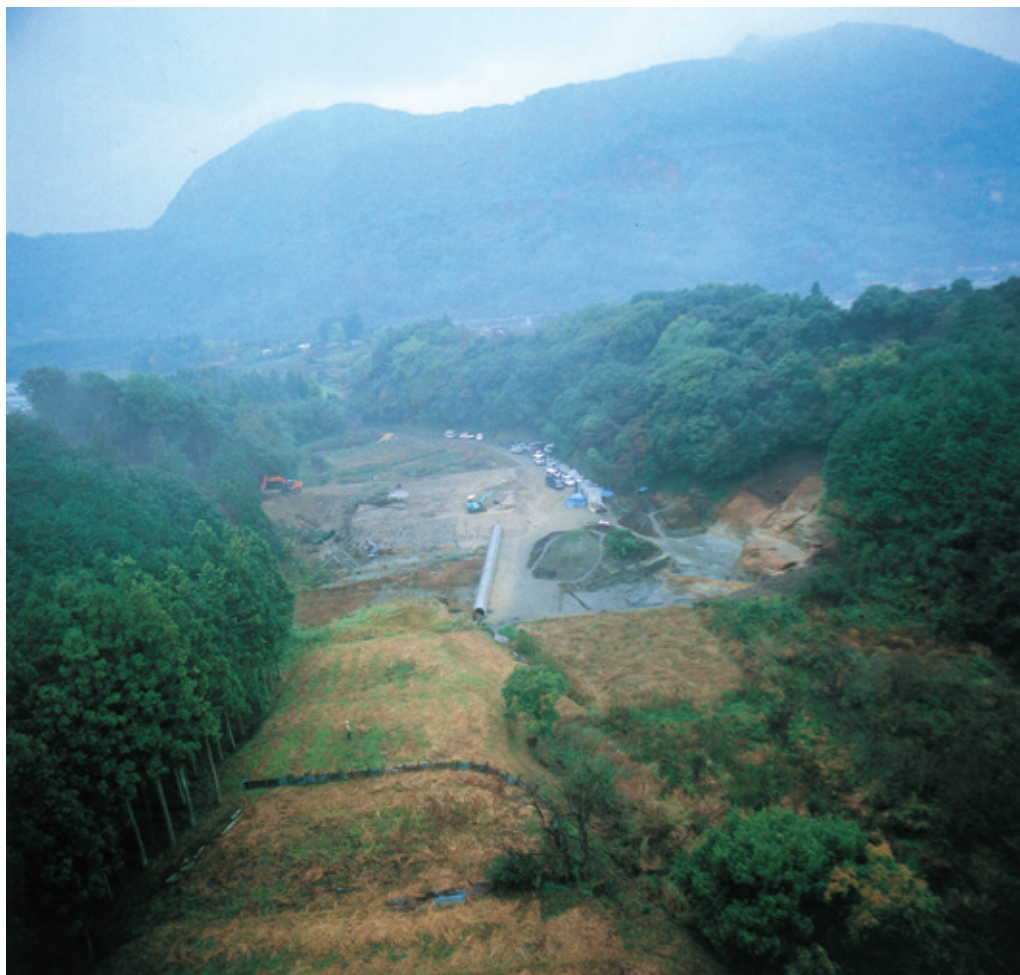
1. 調査地遠景 (東から)
