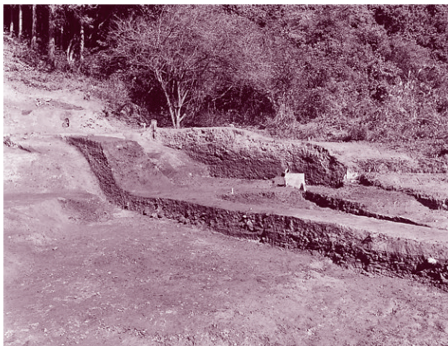
1. 谷部掘削状況② (南西から)
