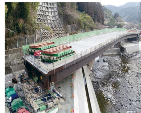
一般国道442号 宮ノ尾橋(八女市)
