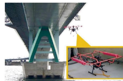
橋梁定期点検の状況
