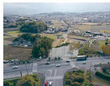
主要地方道 田川直方線 (田川市)
