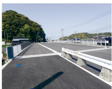
一般国道385号 那珂川拡幅Ⅱ期 (那珂川市)
