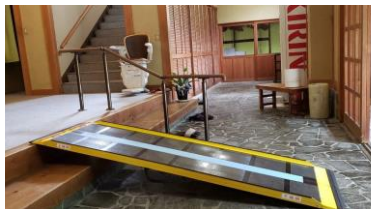
折りたたみ式の簡易スロープの設置
