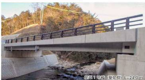
JIS桁の桁高1200mmを900mmに低減(25%減)
