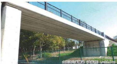
JIS桁の桁高600mmを450mmに低減(25%減)
