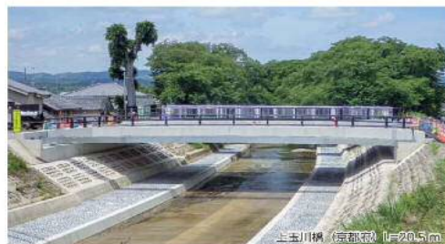
JIS桁の桁高800mmを550mmに低減(31%減)
