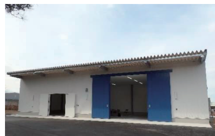
新設した備蓄資機材の倉庫
