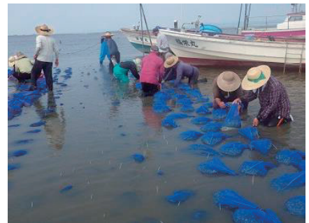
砂利袋の設置作業
