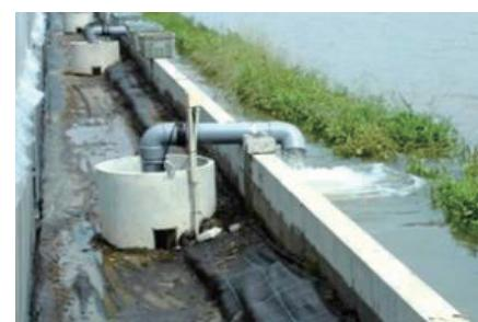
排水ポンプと浸水防止壁による対策
