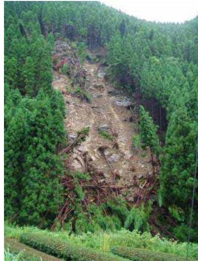
H16年18号台風被害地
