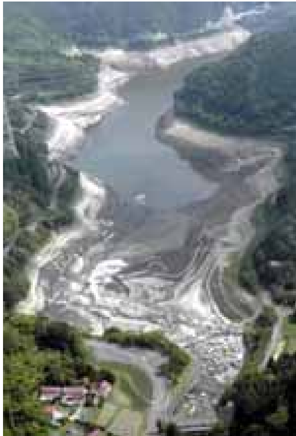
県内ダムの湧水状況 H17年6月
