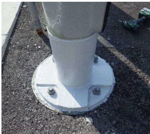
↑沖縄県 国道照明柱
