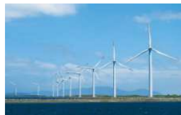
風力発電施設
