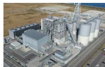
バイオマス発電施設
