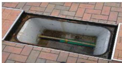
水素パイプライン
