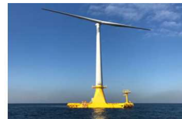
浮体式洋上風力発電
