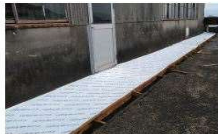
建物の犬走り
