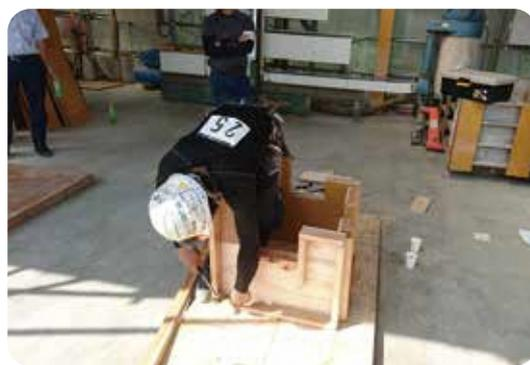
技能実習生の技能検定(型枠施工)
