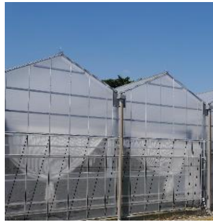
耐候性ハウスの整備
