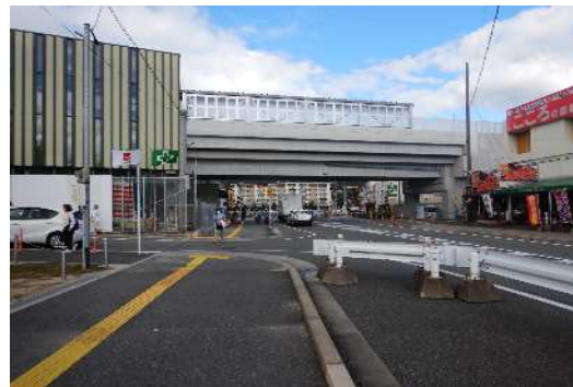
(下大和1号踏切) 高架橋の建設が完了しています。
