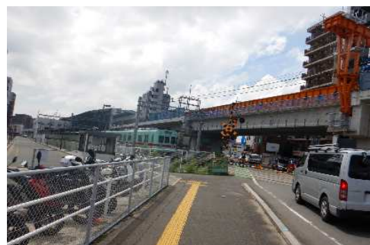
(白木原3号踏切) 高架橋の建設が進んでいます。
