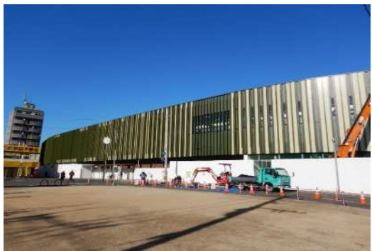
(下大和駅(西口)) 仮駅舎横の元の駅舎跡に新駅舎を建築しています。
