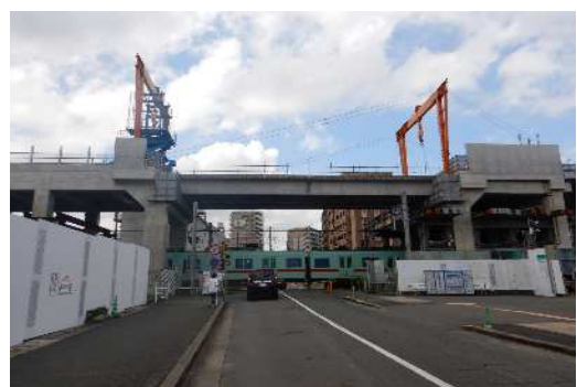
(白木原1号踏切) 高架橋の建設が進んでいます。
