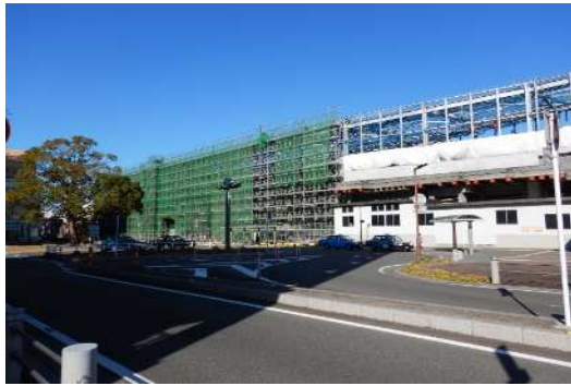
(建築中の白木原駅(西口)) 現駅舎の真上で新駅舎の建築が進んでいます。
