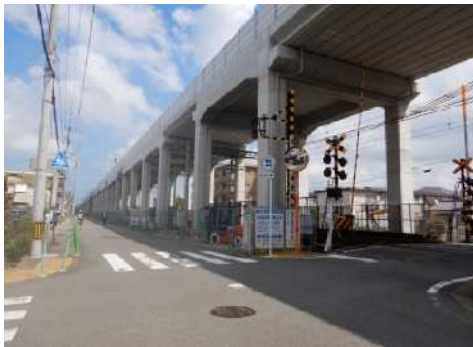
(福岡市境～春日原駅) 高架橋の建設が進んでいます。
