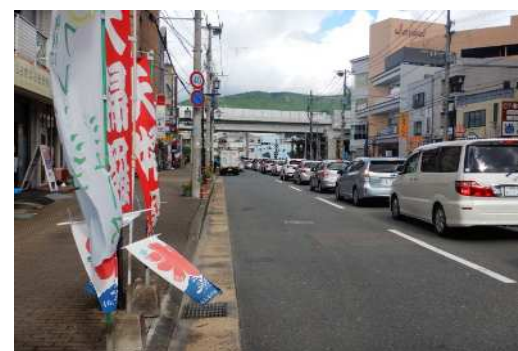
(春日原6号踏切) 高架橋の建設が完了しています。
