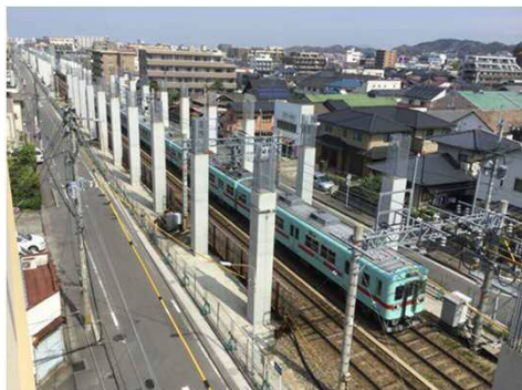
(春日原市境～春日原駅) 高架橋の建設を進めており、線路の両側には高架橋の柱が 建ち並んでいます。
