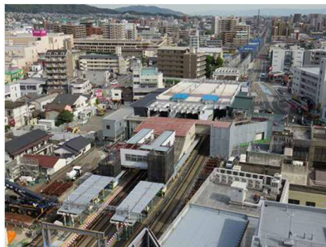
(春日原駅周辺) 駅部では既設駅舎の解体が進められており、その後順次 高架構造物を建設していきます。 駅部の南側は高架構造物が建設されていて、引き続き施工 を行います。
