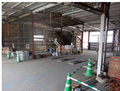
内部解体中の状況
