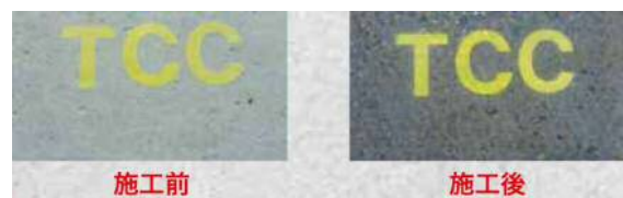
施工前後状況
